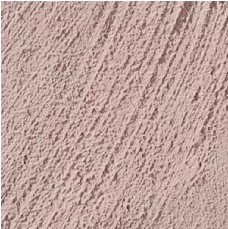
Lehmputzstruktur clay plaster structure
